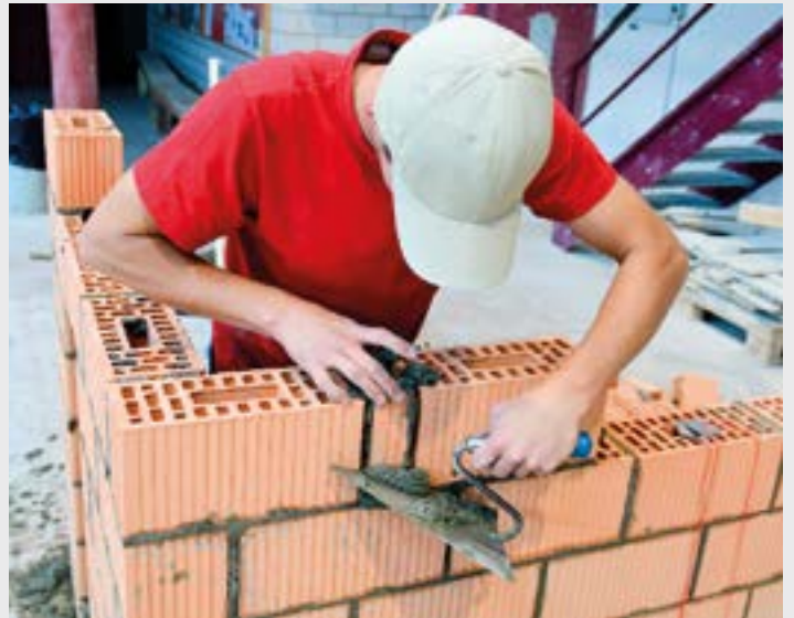
Ein Kandidat beim Erstellen eines Backsteinmauerwerks.
